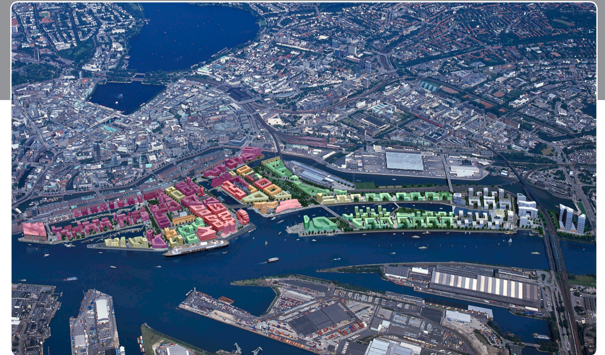
Abb. 117/1: Luftbild mit Illustration der Hafencity; Hafencity Hamburg GmbH, Stand Februar 2012
