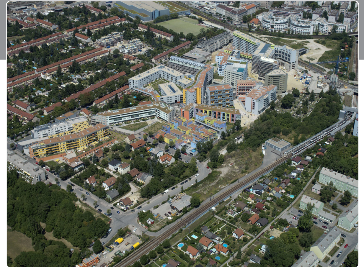
Abb. 127/1: Luftaufnahme Kabelwerk Wien Meidling von Südosten; Stadt Wien, © Wien-Media, 2007
